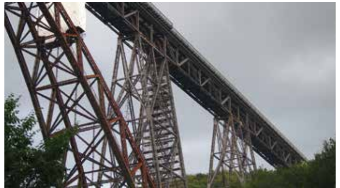
Detailaufnahme der Müngstener Brücke
