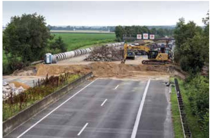
Reparaturarbeiten an der Autobahn A61 bei Swisttal, wo sie der Schiessbach beschaedigt hat.
