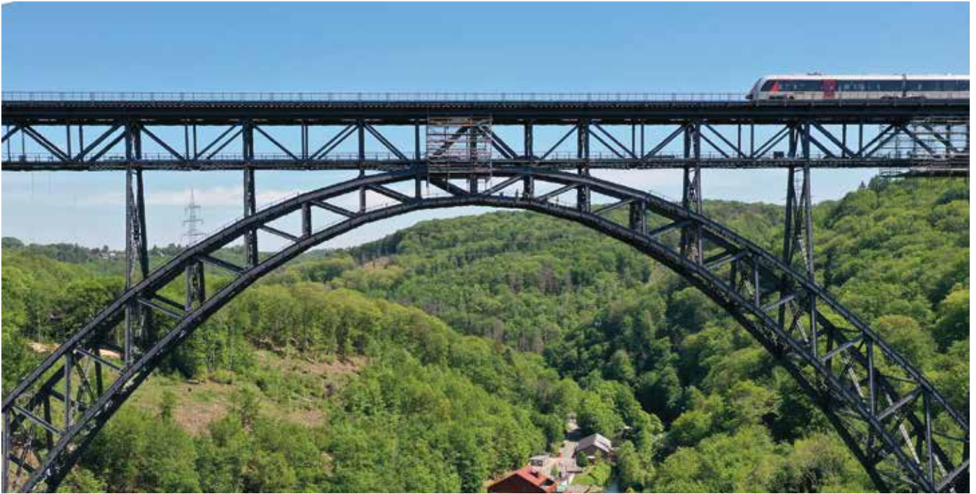
Der erneuerte Wartungssteg der Müngstener Brücke ermöglicht auch geführte Begehungen für Besucher
