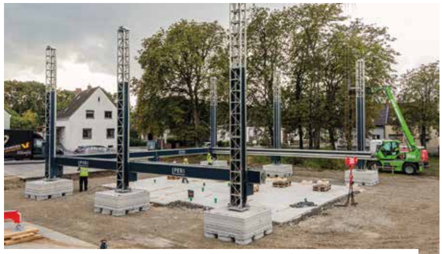
Druck des ersten Wohnhauses in Deutschland mit dem Portaldrucker BOD2 in Beckum.
